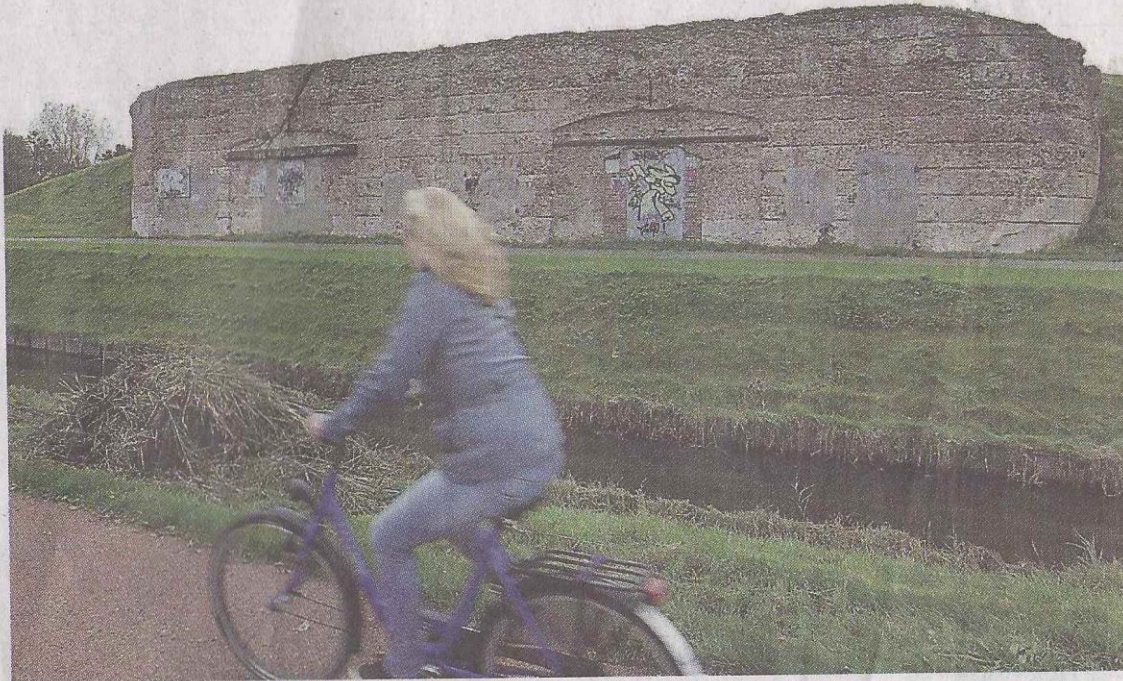
De bomvrije remise in De Linie wordt expositieruimte.
